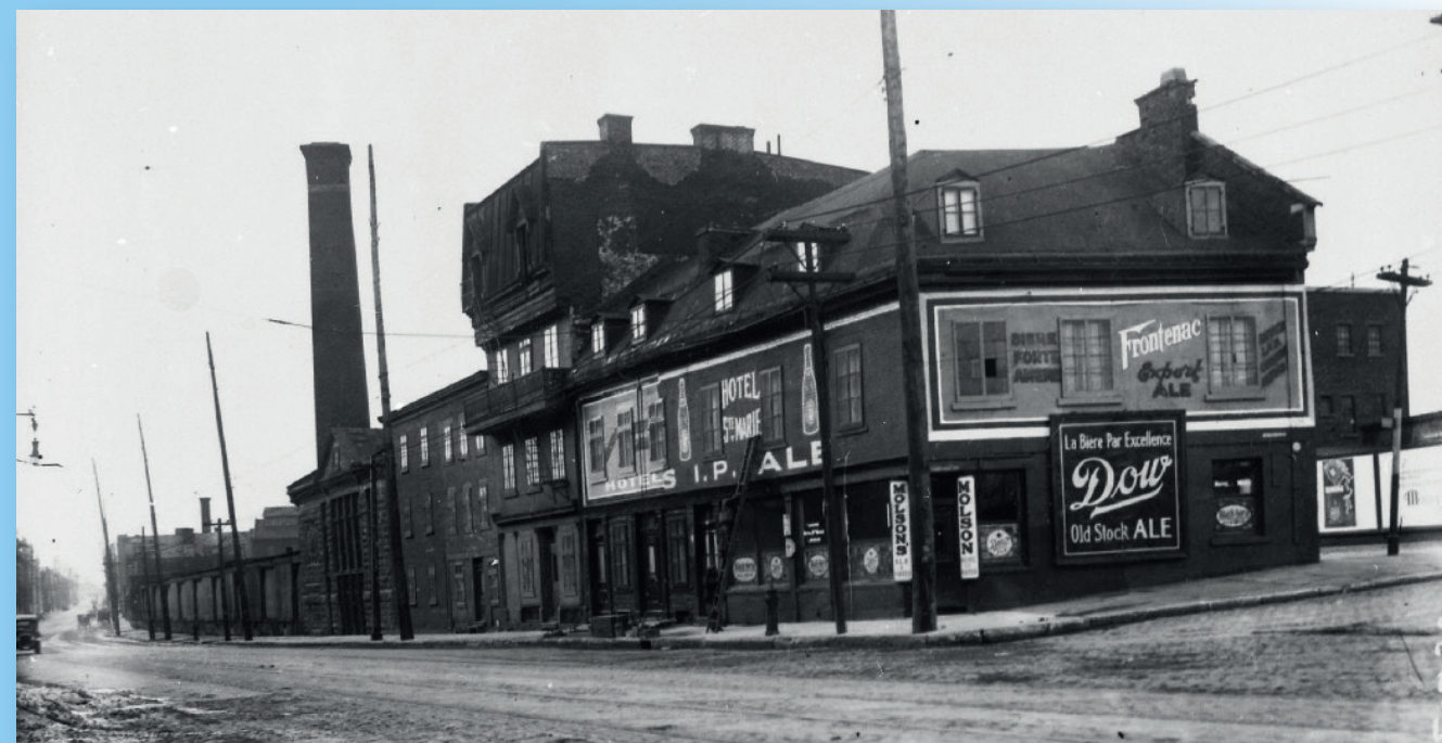
Photographie prise en 1921 à l'angle des rues Notre-Dame et Lorimier. Il est possible d'y apercevoir l'hôtel Sainte-Marie et la station de pompage Craig (à gauche de la photo, où se situe la grande cheminée).
